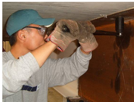
(d) Tightening with torque wrench
